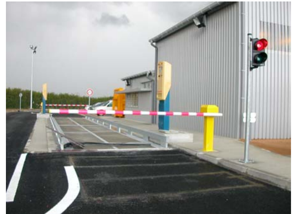
Exemple de configuration d'un pont bascule, deux bornes « Sentinelle » et deux barrières
